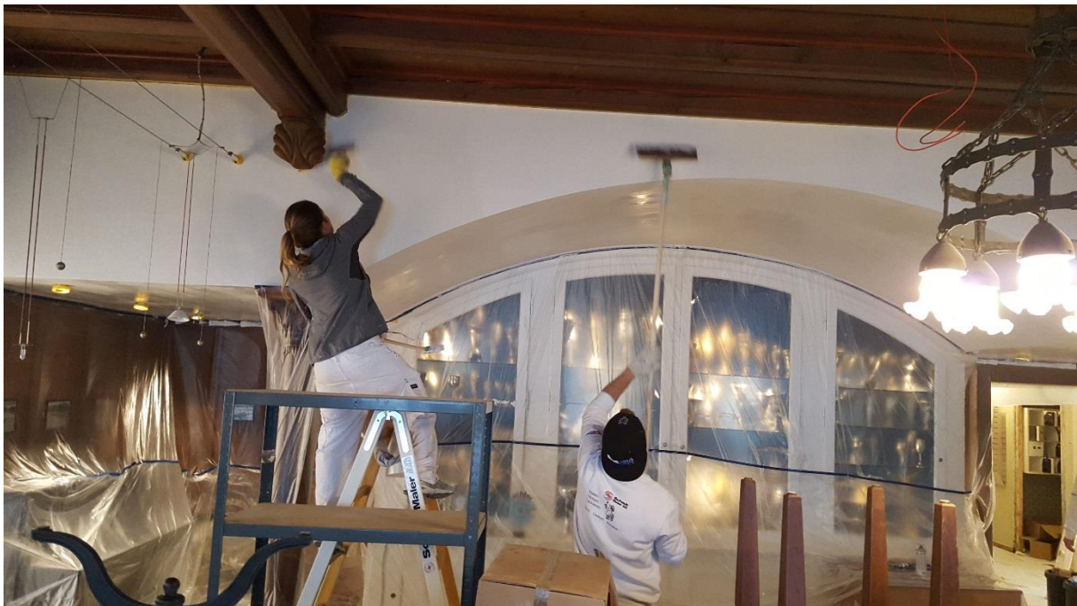
Frauenpower bei der Renovation des Clubzimmers
